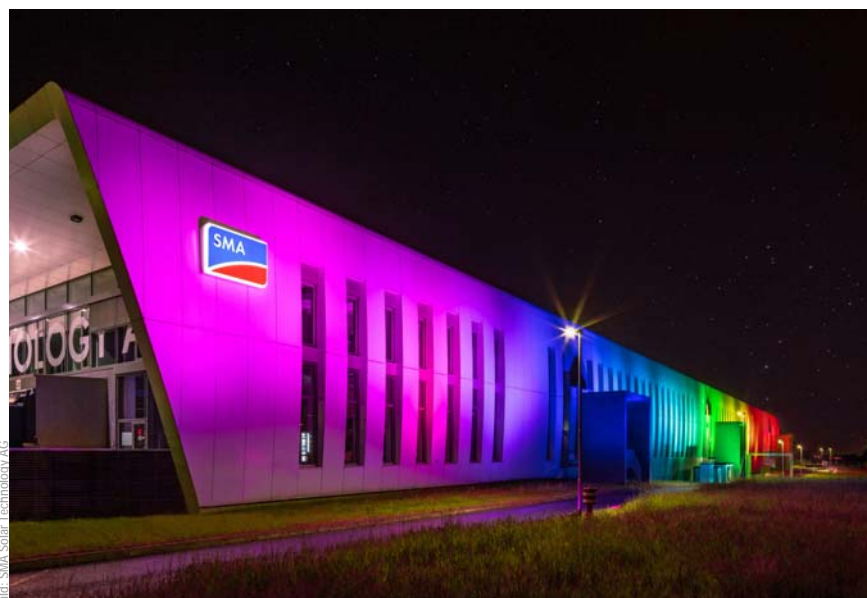
Bild: SMA Solar Technology AG
