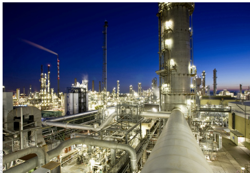
Quelle: BASF SE
