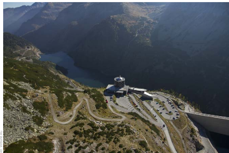
Bild: Verbund AG
