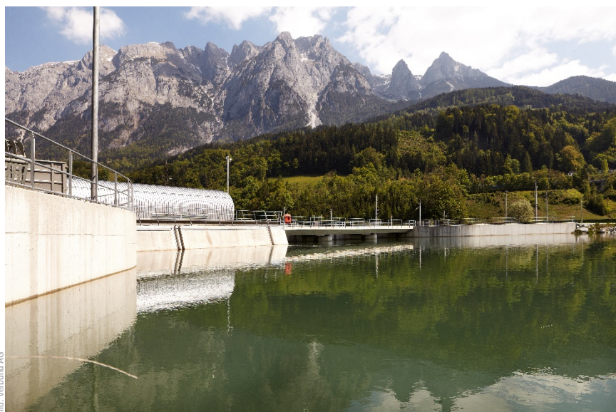
Bild: Verbund AG
