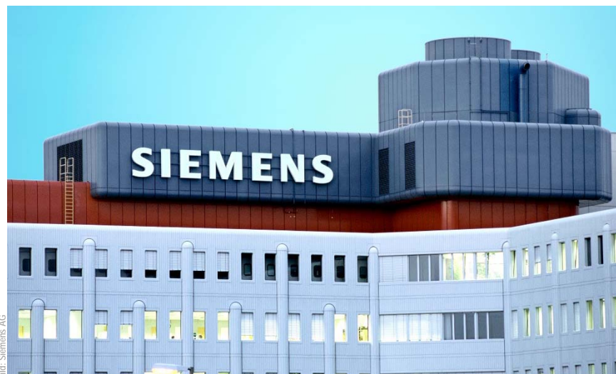
Bild: Siemens AG
